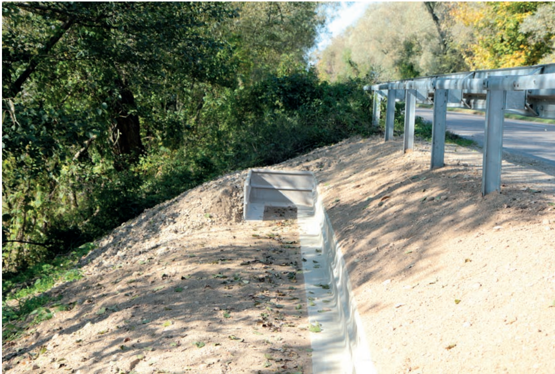
Odpowiednio wyprofilowane końcowe odcinki barier naprowadzających
